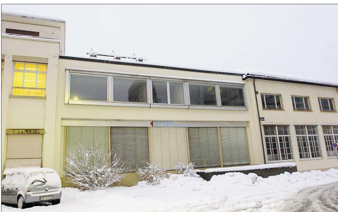
EX-USINE VOUMARD A l'insu du propriétaire, le FX Groupe a entrepris dans les locaux qu'il voulait acheter des travaux de rénovation, qu'il n'a pas payés, comme les salaires de ses employés. (RICHARD LEUENBERGER)
